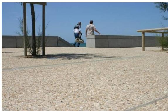
Kombinace světlé barvy a povrchu z porézního betonu (zdroj: [www.stavbaroku.cz](http://www.stavbaroku.cz) ).
