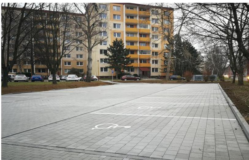
Obrázek: Štěpnice – příklad výměny nepropustných povrchů za propustné a navedení vody do zeleně
