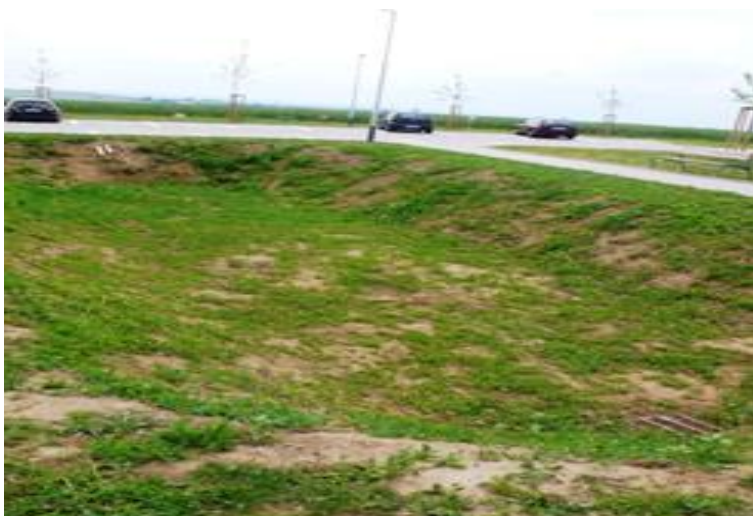
Obrázek: Vsakovací průleh – Q-City, Uherské Hradiště
