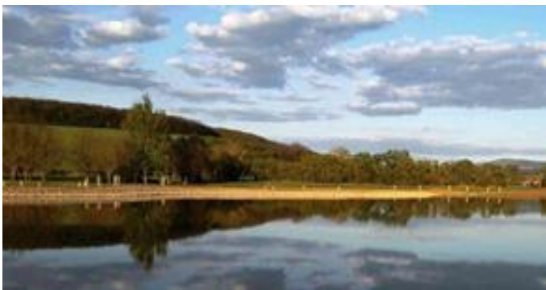
Obrázek: Nově vybudovaná retenční nádrž v Újezdci, řeka Olšava (zdroj: https://www.ub.cz/zpravy/Slavnostni-otevreni-retencni-nadrze )
