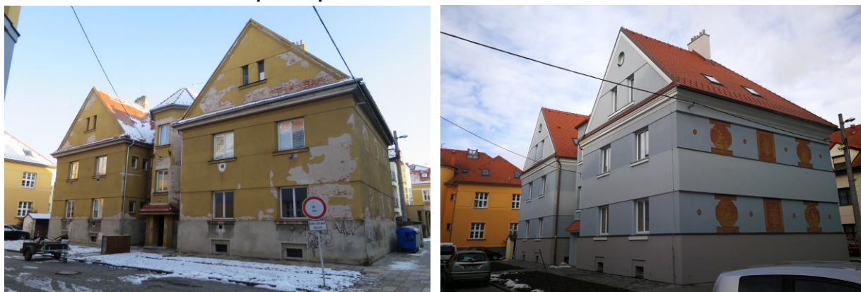
Obrázek 19: BD Kollárova – před a po rekonstrukci
