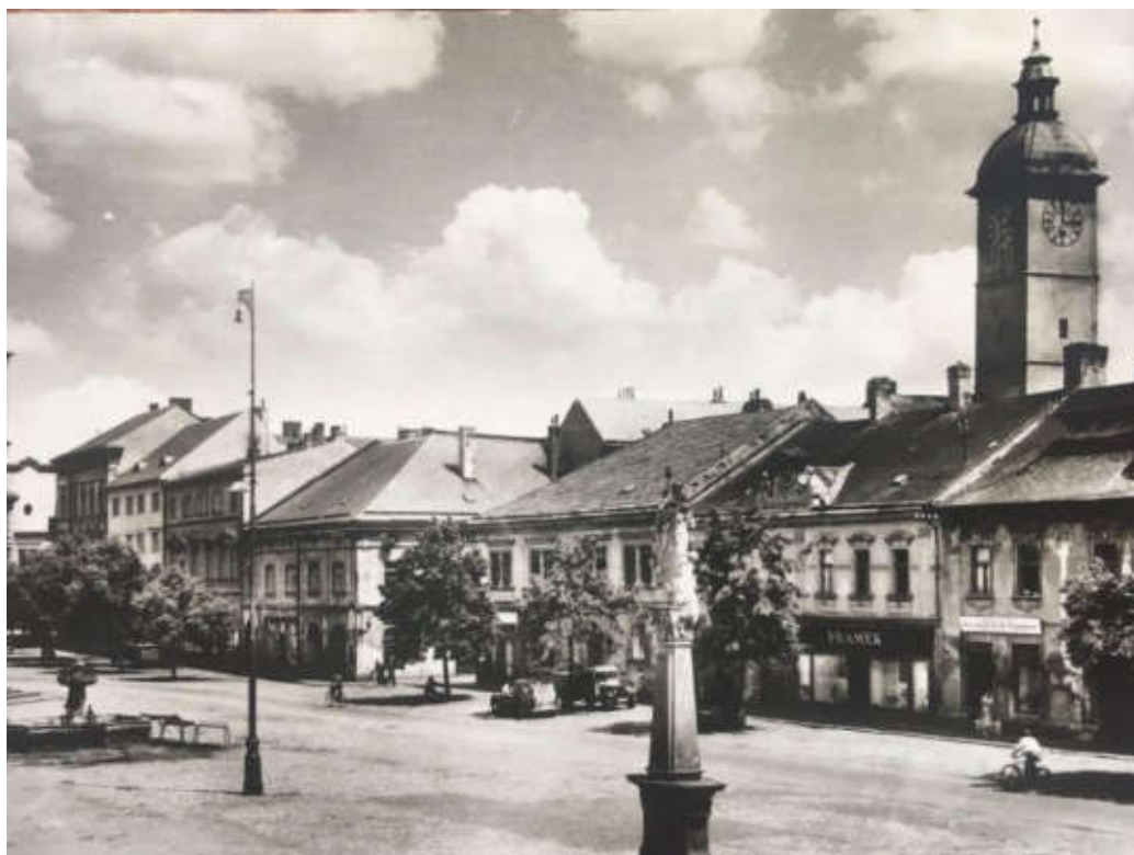
Obrázek č. 235 - Převýšený stožár veřejného osvětlení na Mariánském náměstí
