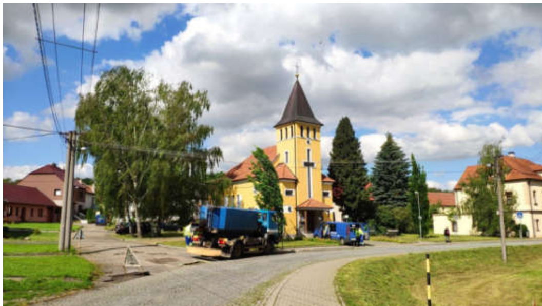
Obrázek č. 115 - Veřejné osvětlení centrálního veřejného prostoru Jarošova jako součást energetických rozvodů. Svítidla jsou osazena na výložnicích ze stožárů energetických rozvodů
