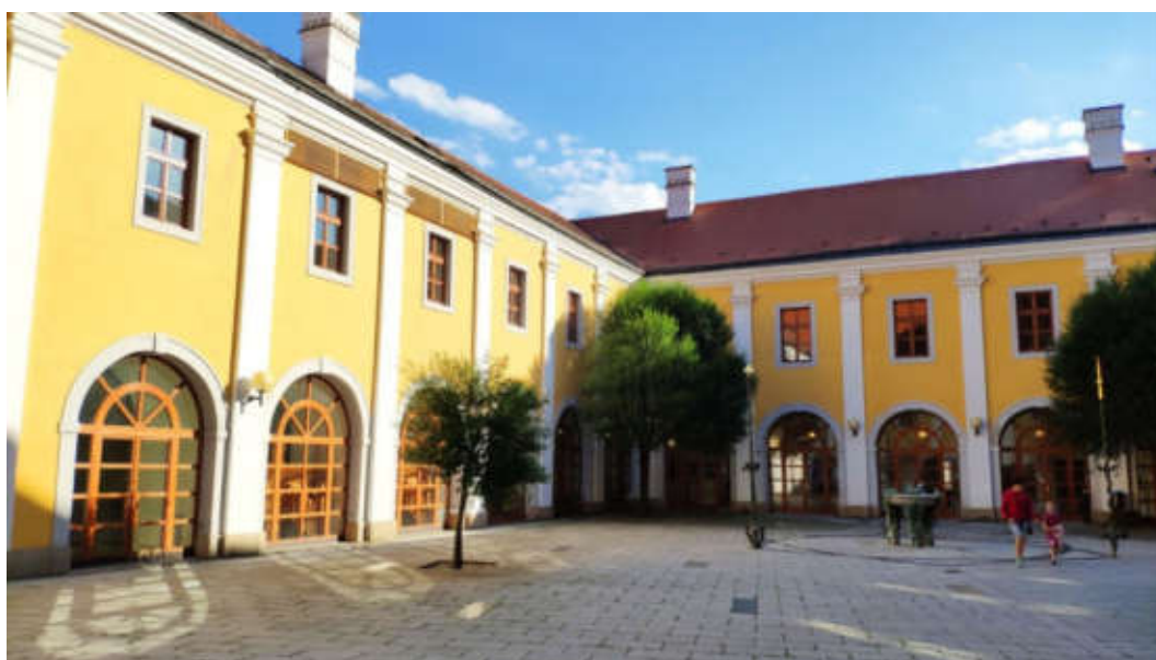
Obrázek č. 134 – Vnitřní prostory Reduty
