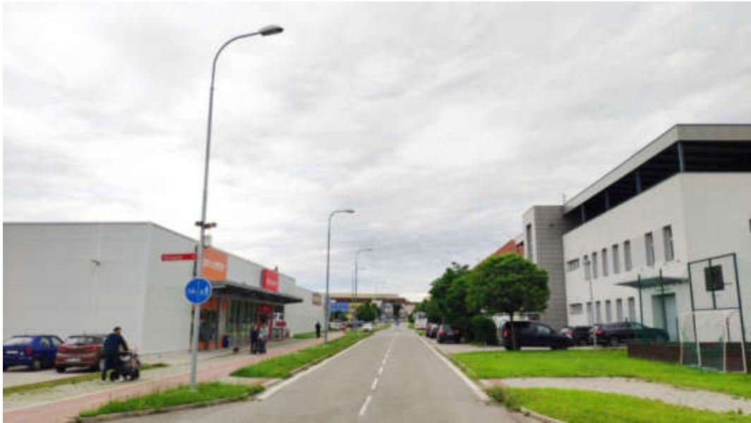
Obrázek č. 104 - Charakter VO v okolí obchodního centra Kaufland – ulice Města Mayen - světelné zdroje na vysokých stožárech s výložníkem. V ulicích mimo základní komunikační systém města by bylo vhodné zvážit snížení výšky svítidel, pokud to prostorové podmínky v ulici umožňují
