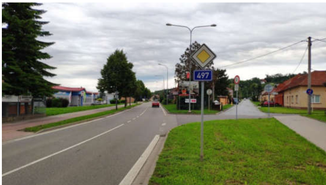
Obrázek č. 102 - Charakter VO v ulici Sokolovská – silnice II/497 – světelné zdroje na vysokých stožárech s výložníkem
