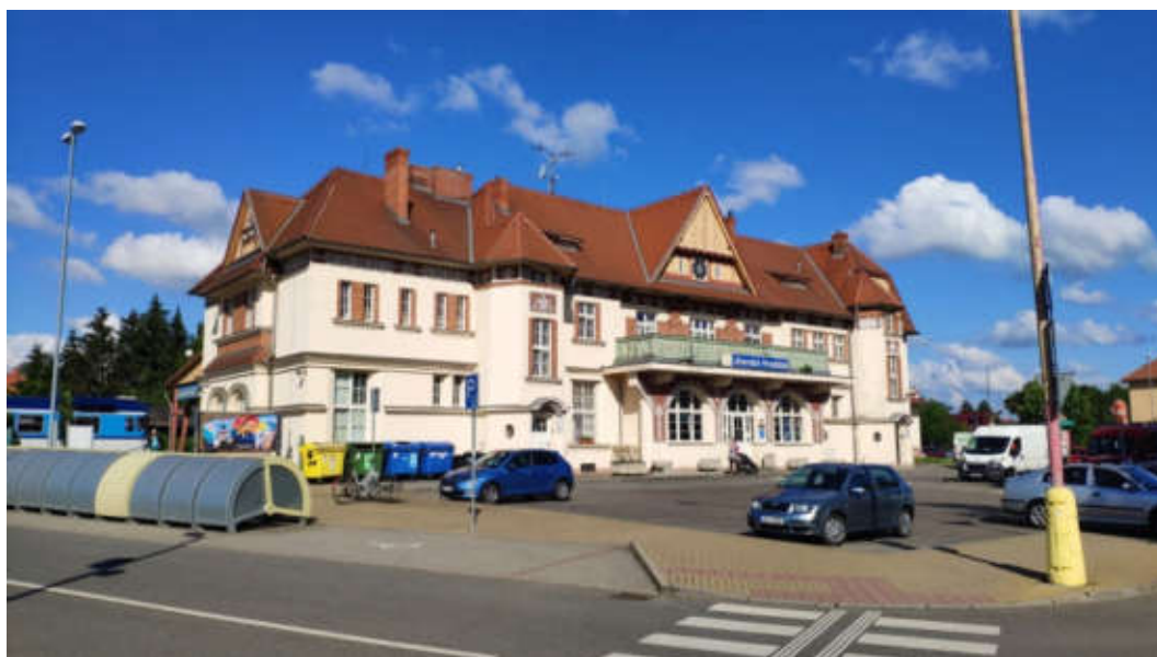
Obrázek č. 165 – Budova vlakového nádraží v Uherském Hradišti
