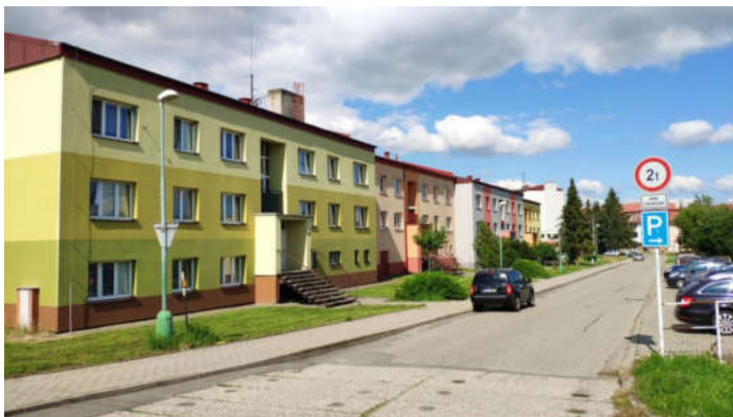
Obrázek č. 116 - Veřejné osvětlení sídliště Louky – svítidla na odstupňovaných stožárech, s patičí, svítidlo bez důrazu na design
