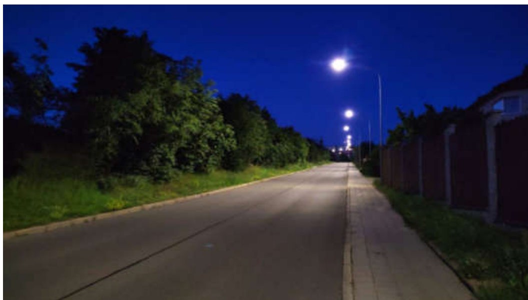
Obrázek č. 119 - Charakter VO v ulici Větrná – světelné zdroje na vysokých stožárech s výložníkem, svítidlo bez důrazu na design. Použití LED zdrojů – viditelné kvalitní podání barev
