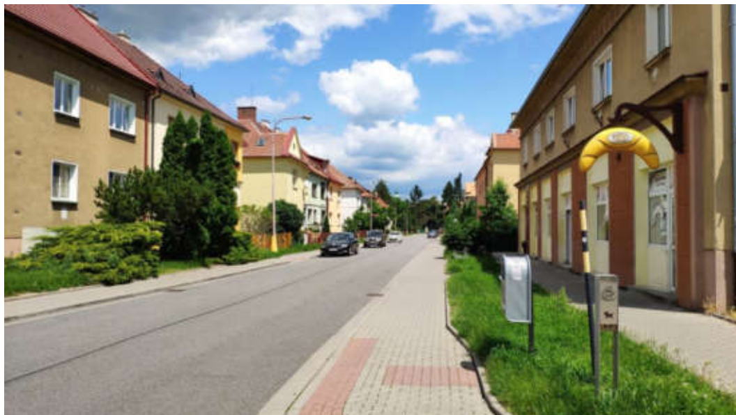
Obrázek č. 93 - Charakter VO na sídlišti Mojmir I v Husově ulici - světelné zdroje na vysokých stožárech s výložníkem, svítidlo bez důrazu na design
