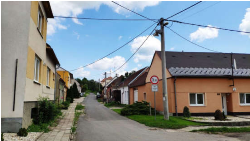
Obrázek č. 128 - Charakter VO v převážné části ulic s obytnou zástavbou - svítidla technického typu jsou osazena na výložnících ze stožárů energetických rozvodů. Svítidlo bez důrazu na design
