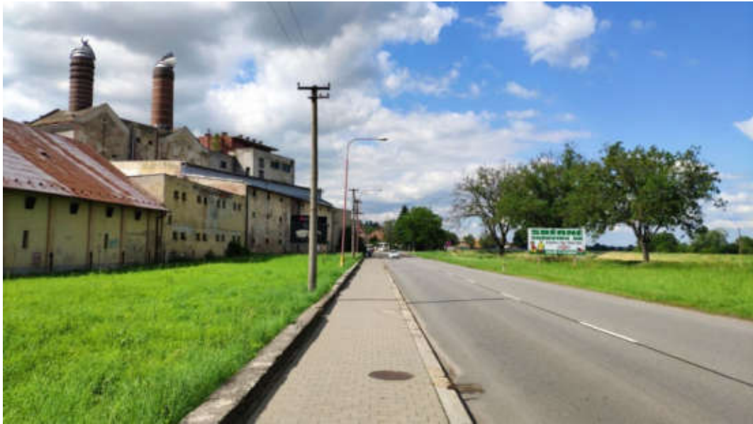
Obrázek č. 117 - Charakter VO v ulici Pivovarská – silnice II/497 – světelné zdroje na vysokých stožárech s výložníkem
