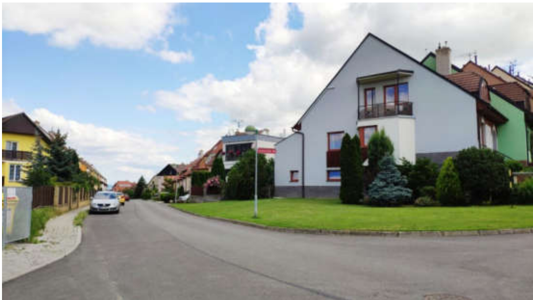
Obrázek č. 107 - Příklad charakteru VO v obytné zástavbě - svítidla na odstupňovaných stožárech, svítidla kulového tvaru
