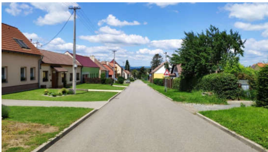
Obrázek č. 131 - Charakter VO v ulicích s obytnou zástavbou – svítidla technického typu na odstupňovaných stožárech, svítidlo bez důrazu na design
