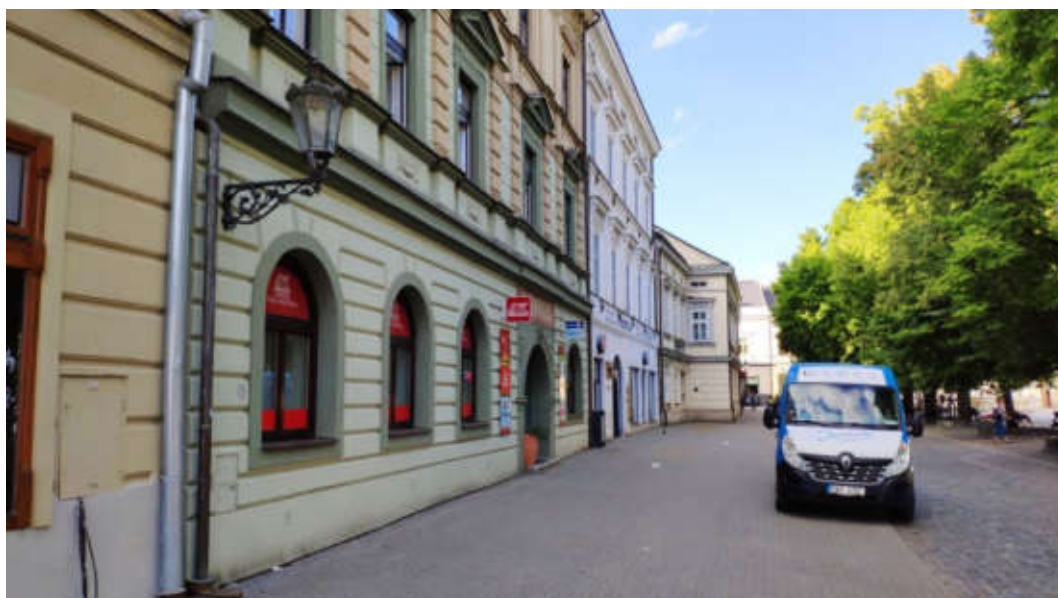
Obrázek č. 70 - Historické/historizující lucerny na konzolách na fasádách domů na severozápadní straně Masarykova náměstí
