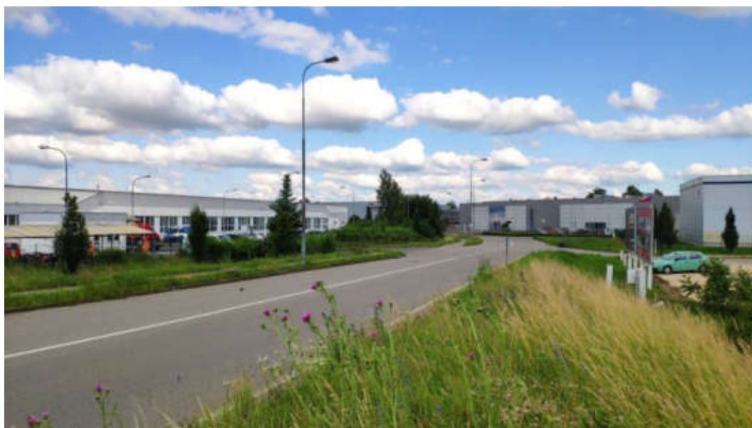
Obrázek č. 113 - Charakter VO v průmyslové zóně západně od ulice Sokolovské
