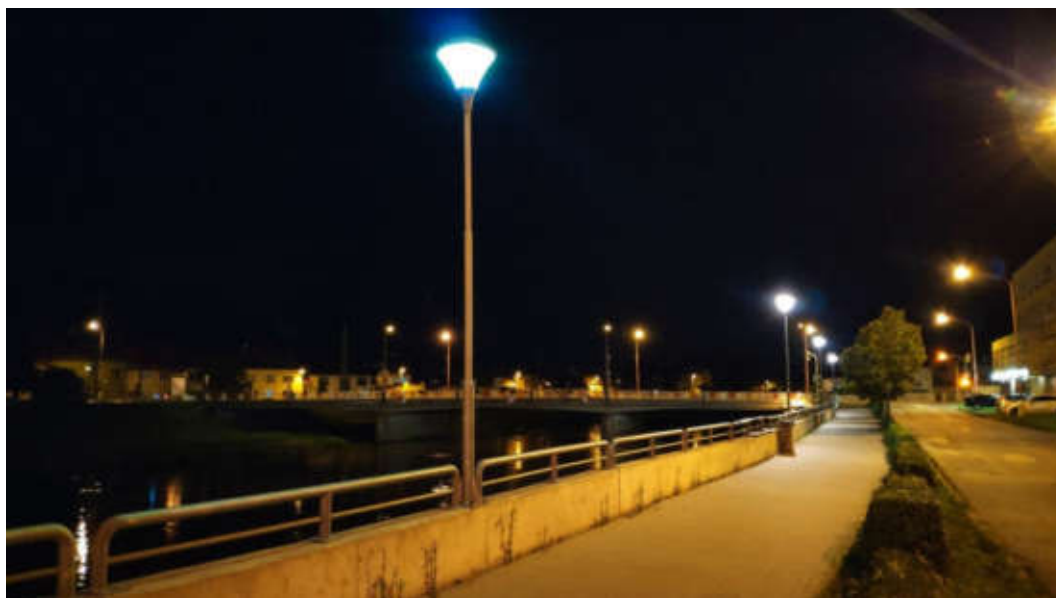
Obrázek č. 91 - Charakter VO na Svatojířském nábřeží, noční pohled. Samostatně osvětlené pochozí plochy chodníku
