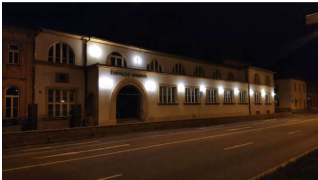
Obrázek č. 155 – Architektonické osvětlení budovy Slovákého divadla
