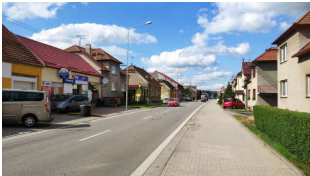
Obrázek č. 112 - Charakter VO v ulici Sokolovská – silnice II/497 – světelné zdroje na vysokých stožárech s výložníkem
