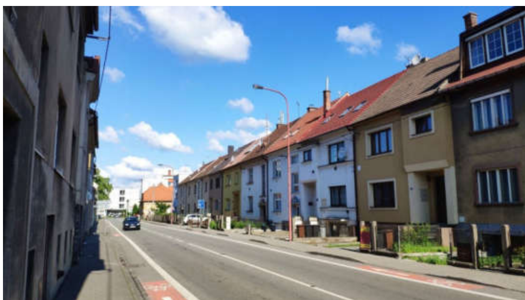
Obrázek č. 86 - Charakter VO v Svatoplukově ulici - světelné zdroje na vysokých stožárech s výložníkem
