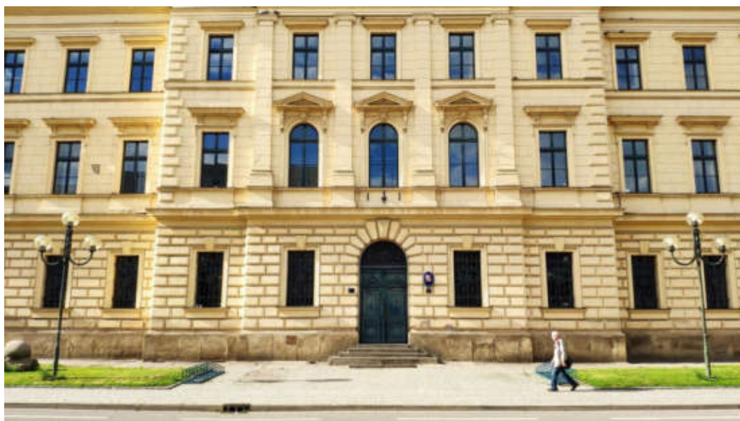
Obrázek č. 84 - Veřejné osvětlení ve Všehrdově ulici před bývalým Justičním palácem. Kulová svítidla, odstupňovaný stožár
