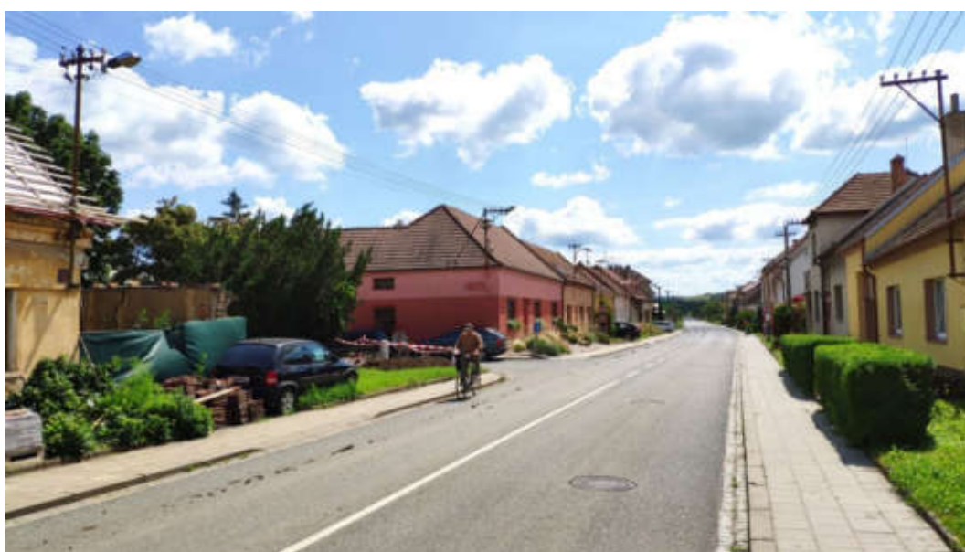
Obrázek č. 121 - Charakter VO v ulici Solná cesta - svítidla jsou osazená na výložnicích ze stožárů energetických rozvodů kotvených na fasádách objektů
