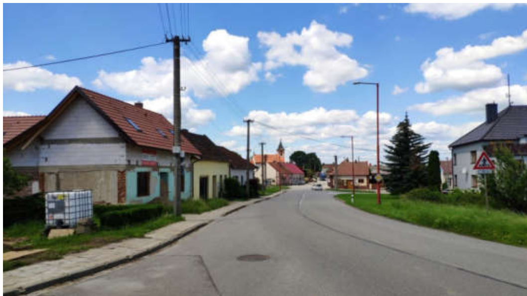
Obrázek č. 44 - Křížení ulic Hlavní a Na Příkopě, Míkovice
