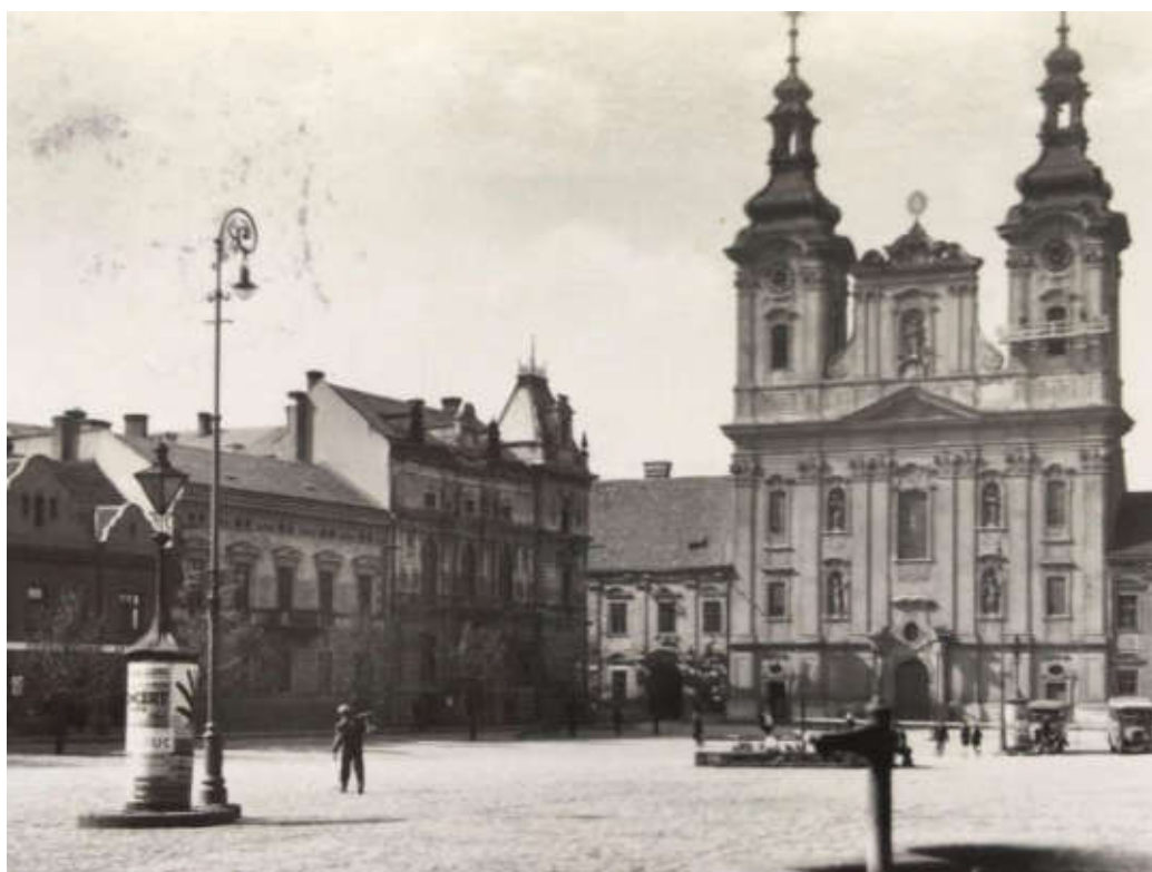
Obrázek č. 236 - Převýšený stožár veřejného osvětlení na Masarykově náměstí
