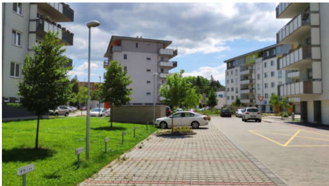
Obrázek č. 97 - Charakter VO na sídlišti Štěpnice v ulici Zahrádky – svítidla na odstupňovaných stožárech, bez patice
