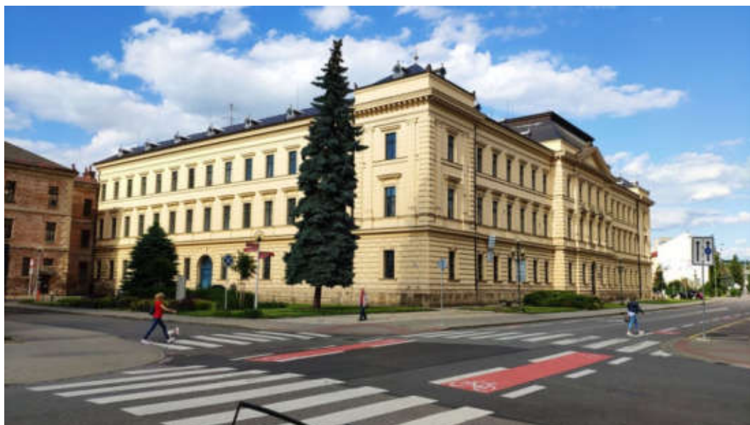
Obrázek č. 160 – Budova justičního paláce v Uherském Hradišti
