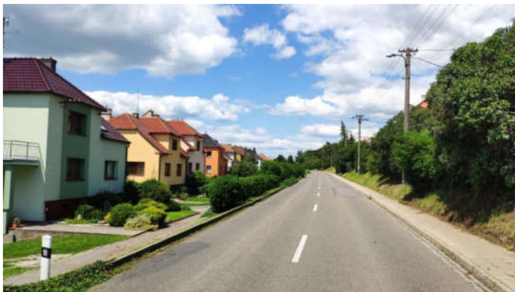
Obrázek č. 120 - Charakter VO v ulici Solná cesta - svítidla jsou osazená na výložnicích ze stožárů energetických rozvodů
