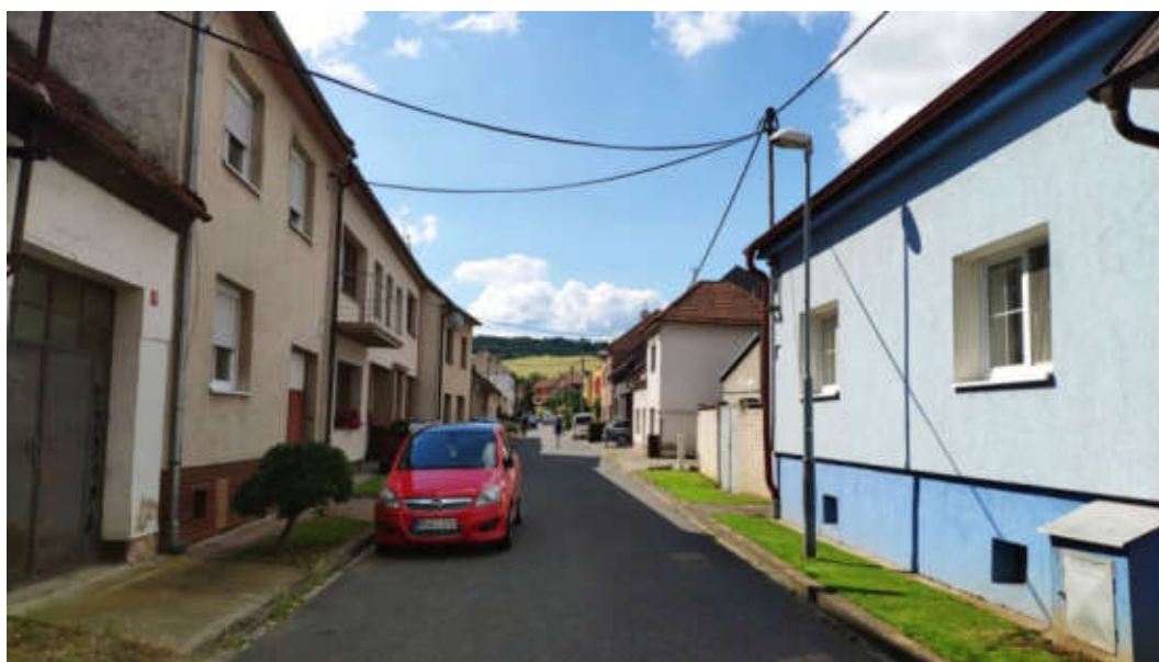
Obrázek č. 114 - Osvětlení uličního prostoru samostatnými svítidly na stupňovitých stožárech, svítidlo bez důrazu na jeho design
