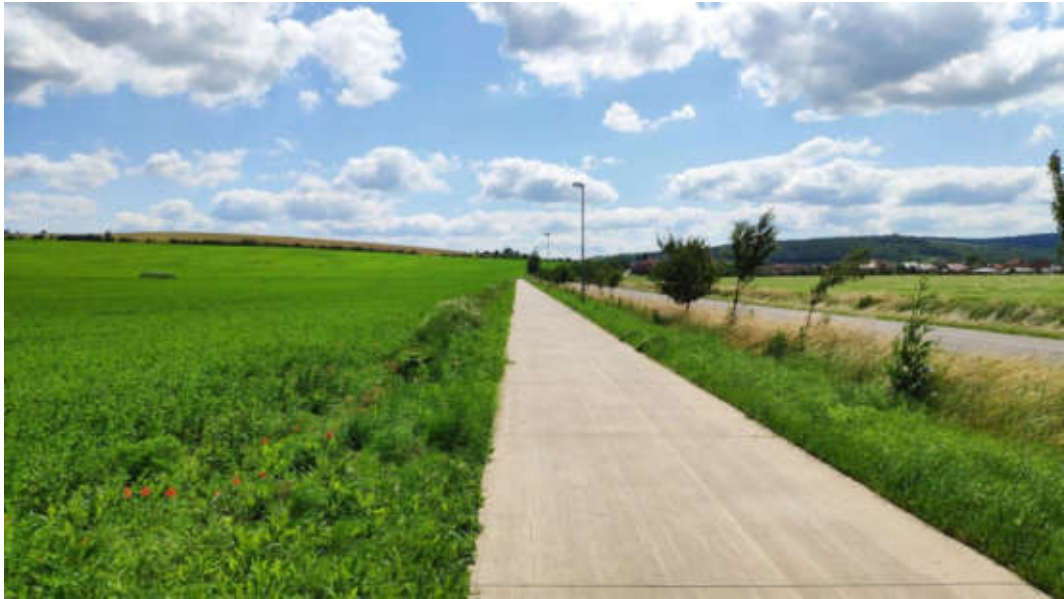
Obrázek č. 125 - Veřejné osvětlení cyklostezky mezi Sady a městskou částí Vésky. Svítidla technického typu na odstupňovaných stožárech
