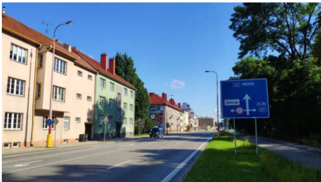
Obrázek č. 88 - Charakter VO na třídě maršála Malinovského (silnice I/55) - světelné zdroje na vysokých stožárech s výložníkem. Svítidlo a stožár bez důrazu na design
