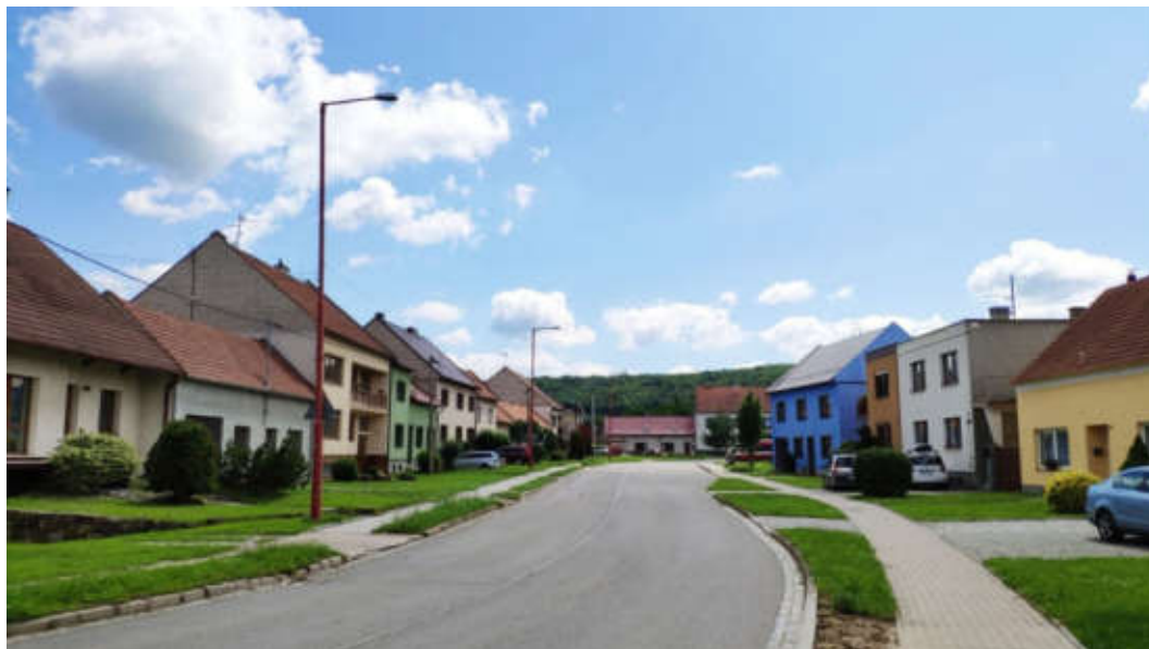
Obrázek č. 130 - Charakter VO v ulici Na Příkopě – silnice III/05014 – světelné zdroje na vysokých stožárech s výložníkem
