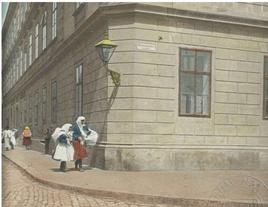
Obrázek č. 232 - Bližší pohled na výše uvedený typ historického svítidla. Patrná je zdobná litinová konzola, čtvercový půdorys svítidla i výrazné rozevření bočních stěn
