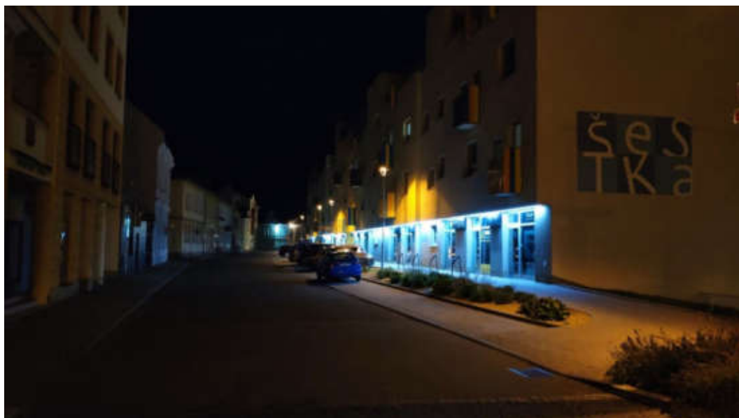
Obrázek č. 81 - Příklad nevhodného řešení osvětlení parteru objektu. Osvětlení objektu je příliš intenzivní a má nevhodnou náhradní teplotu chromatičnosti světelného zdroje – ve vztahu k základnímu osvětlení uličního prostoru. Lepším řešením by v tomto případě bylo prosvětlení výloh komerčních ploch méně intenzivním světlem obdobné náhradní teploty chromatičnosti světelného zdroje jako základní osvětlení
