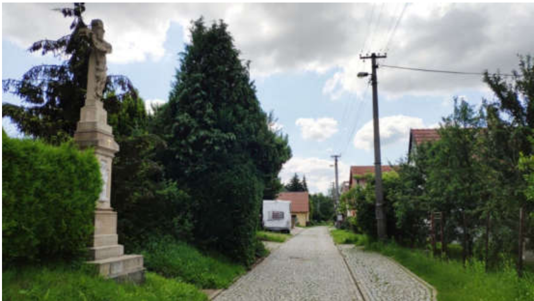
Obrázek č. 111 - Charakter VO v ulici Vinohradská - svítidla jsou osazena na výložnicích ze stožárů energetických rozvodů
