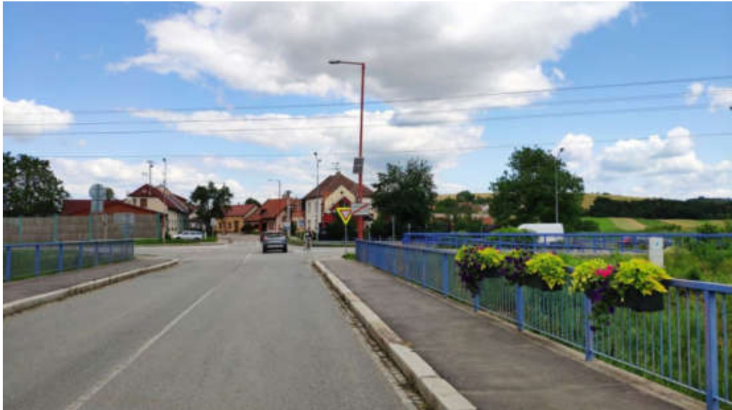
Obrázek č. 127 - Charakter VO úseku silnice I/50 – světelné zdroje na vysokých stožárech s dvojitým výložníkem
