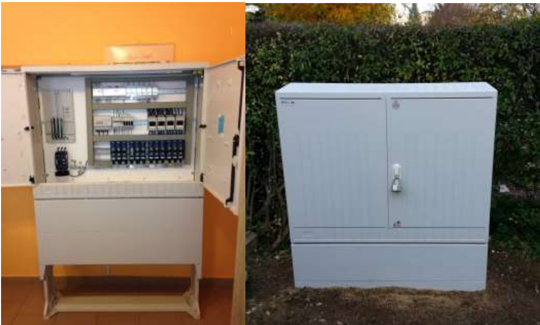
Obrázek č. 6 – Rozvaděč VO s řídicími rozvodnicemi
